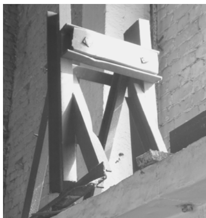
Рис. 4 – Кінцевий упор мостового крана 5т40
